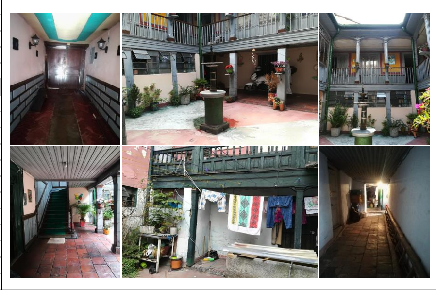
Fuente: Equipo Levantamientos PEMP Patrimonio Inmueble
